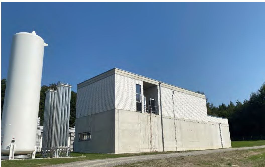
Spurenstoffelimination mit Ozontank
