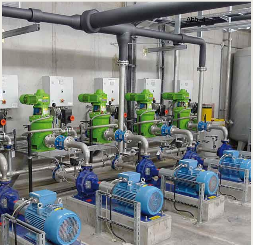
Abb. 3 Flusswasserfiltration für Kälteanlage
