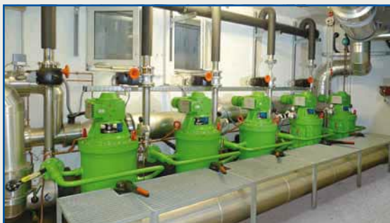
Abb. 3 Flusswasserfiltration für Kälteanlage
